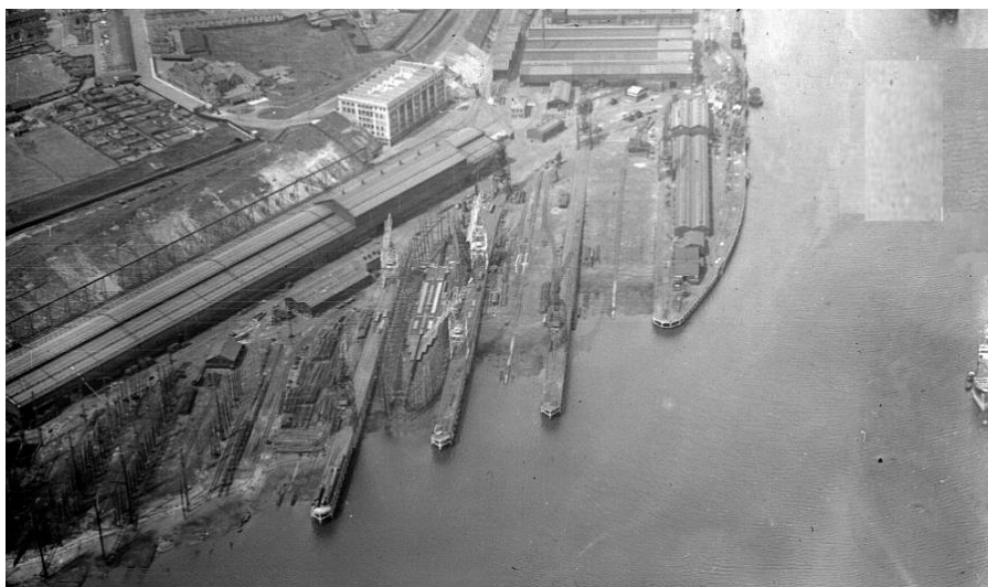
Vedere parțială a șantierelor Vickers
