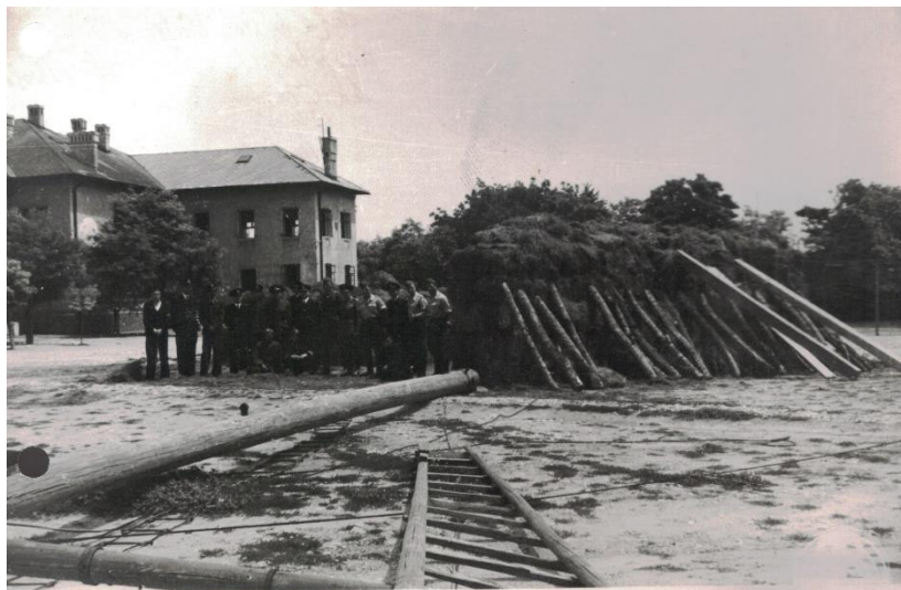
Construirea aripilor clădirii Școlii Navale Constanța, anii '30
