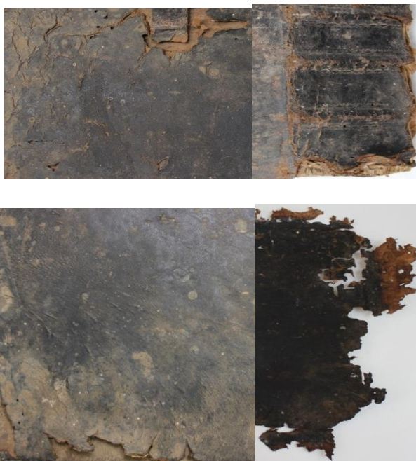
Degradări fizico-mecanice (fisuri, pierderi materiale, rigidizare, piele casantă)
