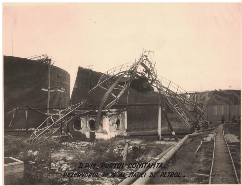
Rezervorul nr. 74 al stației de petrol, după bombardamentele din 1944 (sursa: fototeca MNMR)
