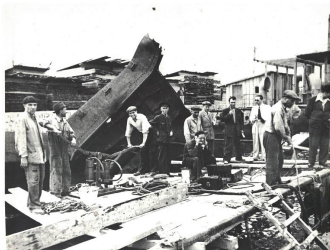
Lucrări de reparații în portul Constanța (sursa: fototeca MNMR)
