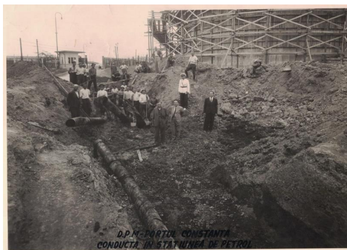
Lucrări de reparații desfășurate la o conductă în Stația de petrol (sursa: fototeca MNMR)
