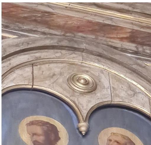
Foto 4. Distanțări ale scândurilor ce formează panoul de lemn policrom
