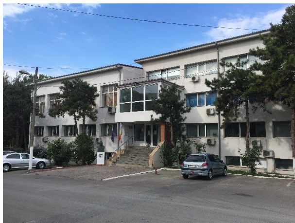
Sediul Institutului Român de Cercetări Marine (I.R.C.M.)
