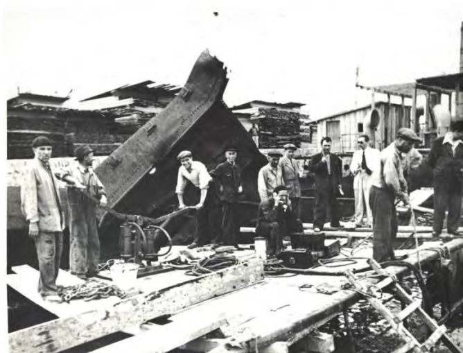
Lucrări de reparații în portul Constanța (sursa: fototeca MNMR)
