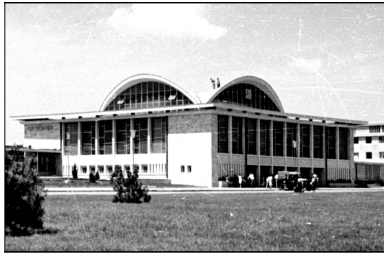
Fig. 2. Corpul principal al gării de călători (anul 1960). Vedere de ansamblu.
