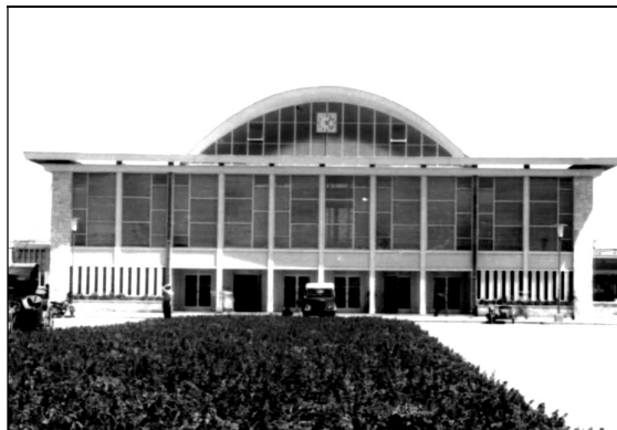
Fig. 3. Corpul principal al gării de călători (anul 1960). Fațada dinspre piața gării.
